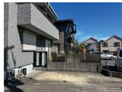
駐車場スペース
